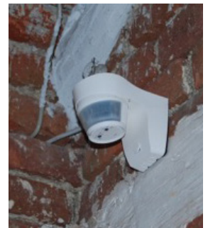
Einschalten der Beleuchtung mittels Bewegungsmelder
