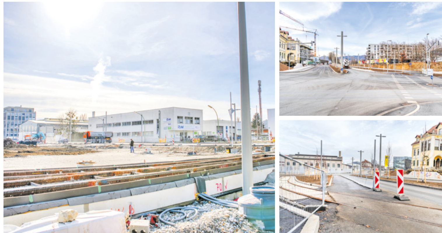
Ausbau. Bim-Verlängerungen nach Reininghaus und in die Smart City laufen, im November gehen die neuen Strecken in Betrieb.
