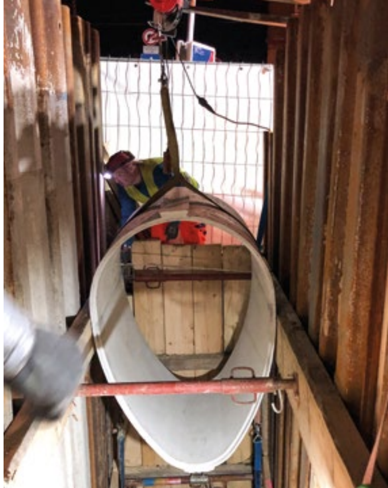
Einbringen eines Kurzrohres in den Montageschacht.
