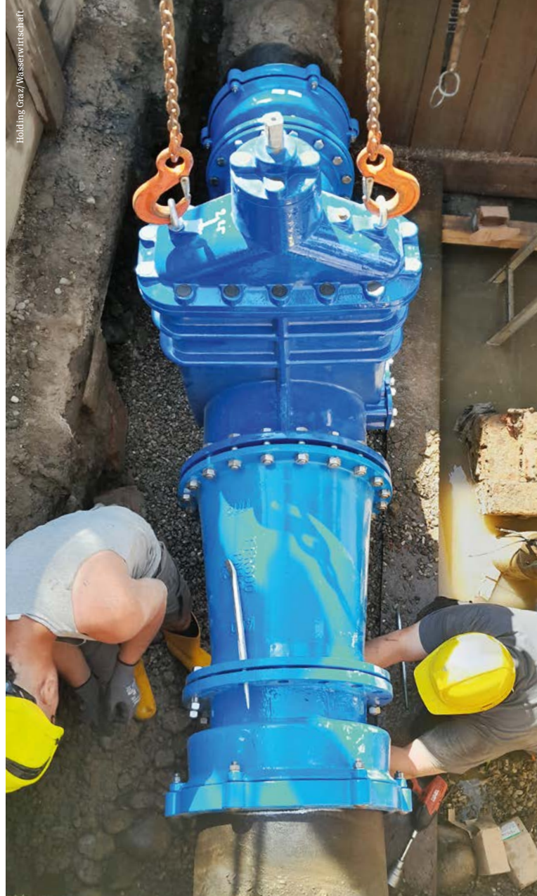
Neue Wasserleitungen: Schiebereinbau in der Körösisstraße
