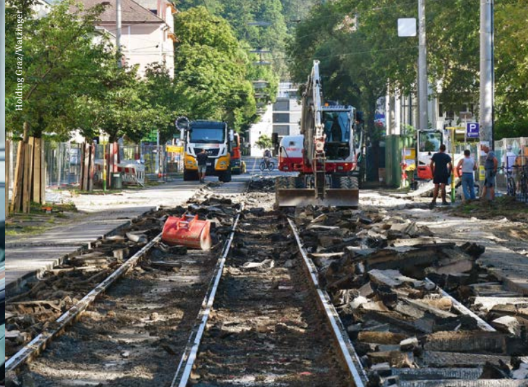
Gleisbauarbeiten im Juli in der Theodor-Körner-Straße
