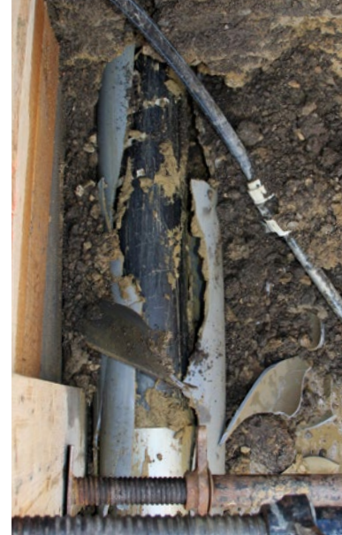
Berstkopf (li.): vor dem Eindringen in das Altrrohr Sprengrung (re.): Berstkopf weitet das alte Rohr auf
