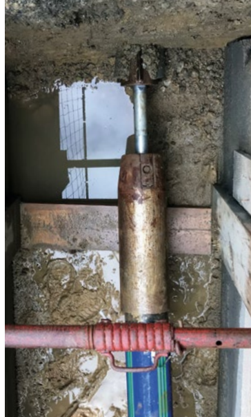
Berstkopf (li.): vor dem Eindringen in das Altrrohr Sprengrung (re.): Berstkopf weitet das alte Rohr auf
