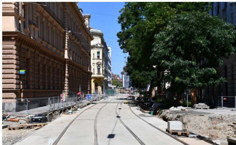
Baufortschritt in der Neutorgasse von März bis August 2023.
