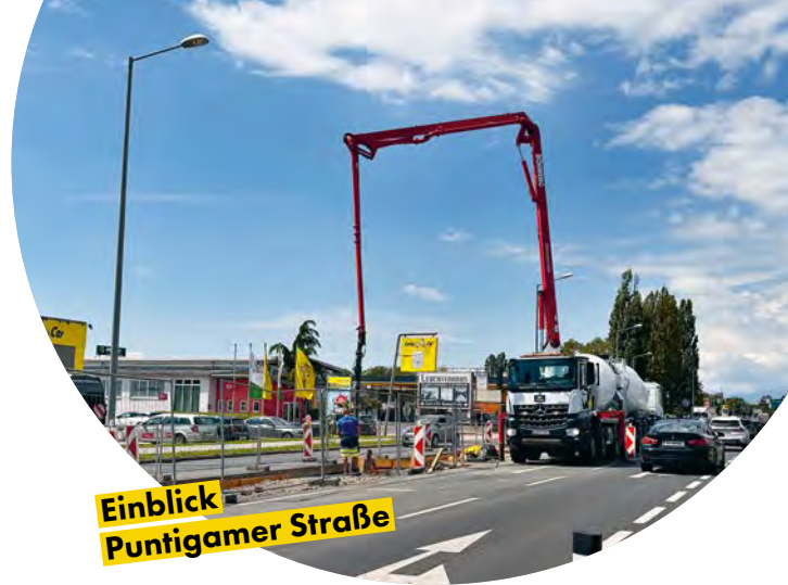
Die ersten Arbeiten sind bereits abgeschlossen – die Fertigstellung erfolgt Ende Oktober.
